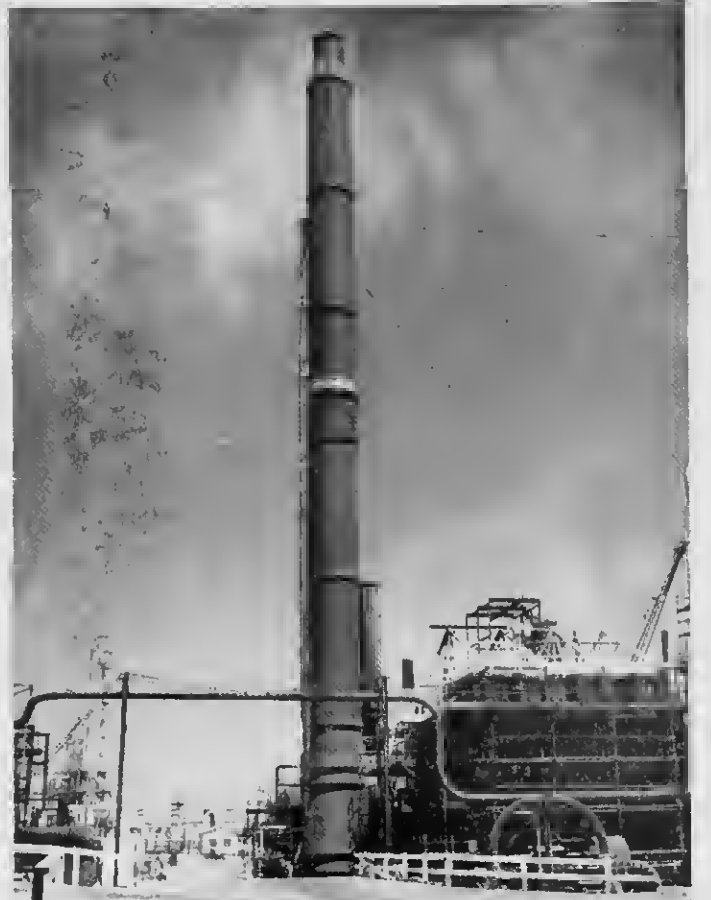
STACK IN PLACE, stiff-legged crane still holds it. STACA NA SU LUGAR, ainda e grua ta tene'le.
